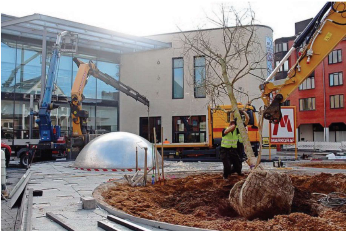
Das Pflanzloch hat einen Durchmesser von sechs Metern und ist von Beton umgeben. Foto: Kaiser
